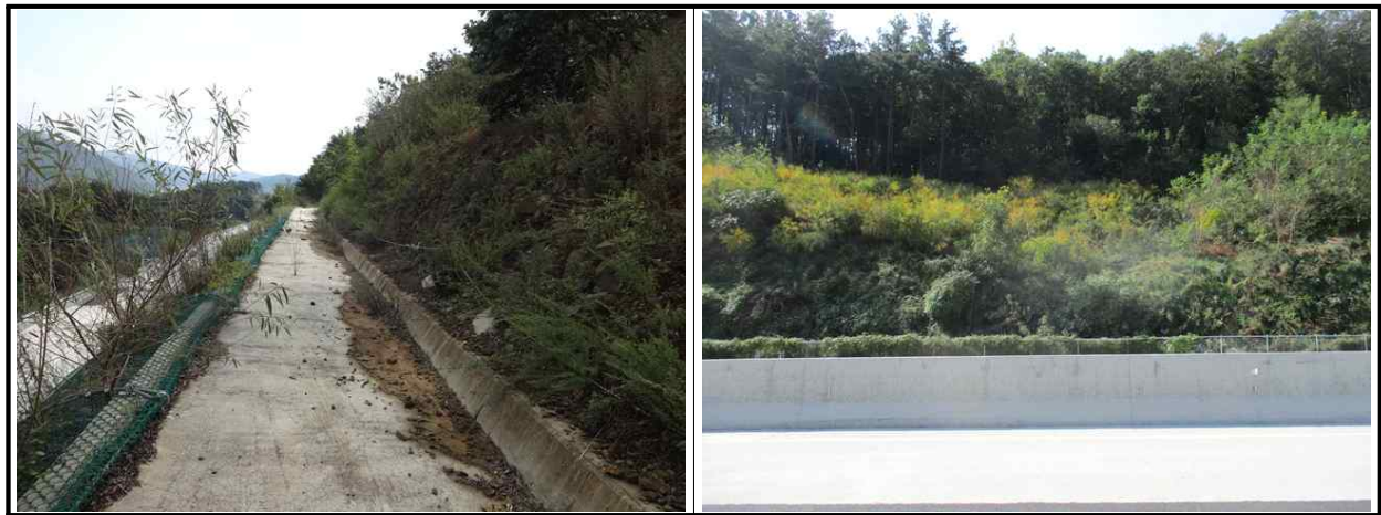
【그림 31.3.3】 배수시설 전경
